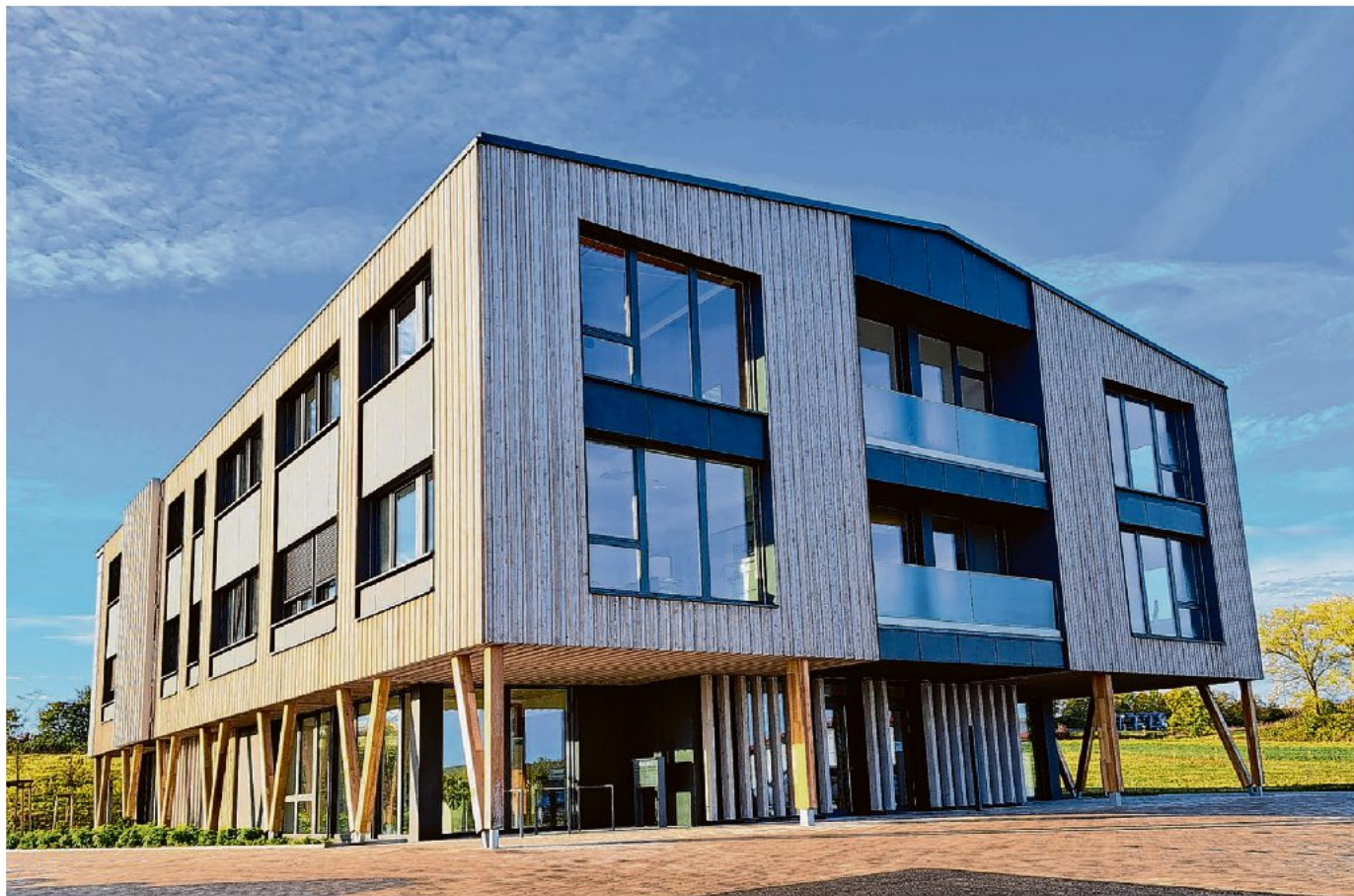
Die Experten von Bauer Holzbau haben bei ihrem Bürogebäude alle Register der Baukunst gezogen.
