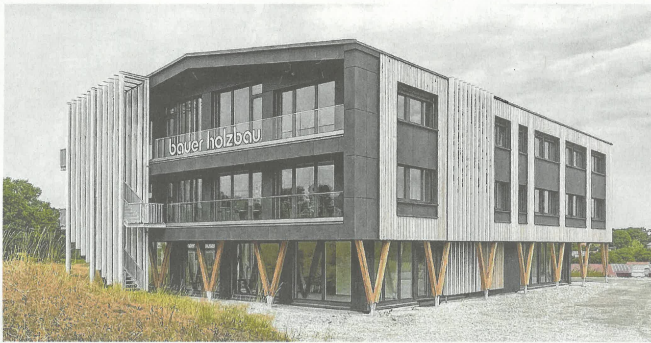
Variation: Das neue Verwaltungsgebäude bietet den Beschäftigten ein hochfunktionelles Arbeitsumfeld und ist gleichzeitig auch Anschauungsobjekt für die vielfältigen Gestaltungsmöglichkeiten des modernen Holzbaus.
