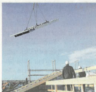
Schnelligkeit: Die Vorfertigung der Bauteile (re.) macht die serielle Produktion weitgehend witterungsunabhängig und gewährleistet zudem eine zügige Montage auf den Baustellen vor Ort (li.).
